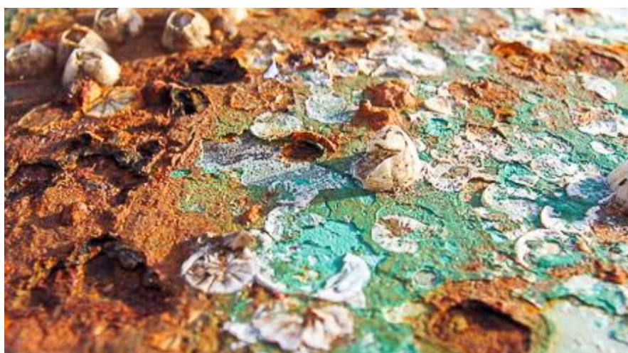
Fot. 2. Biokorozja metalu powodowana przez mikroorganizmy
